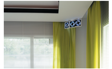
図40 サーキュレーターで温度ムラを調整
