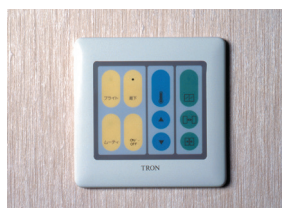
図5 スイッチはTRON作法に従っており統一的に操作できる
