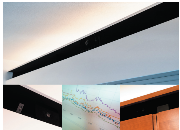
図55 150個のセンサーを性能の低下なくかつ存在感なく設置するために、折り上げ天井の周囲に黒のスリットを作って設置
