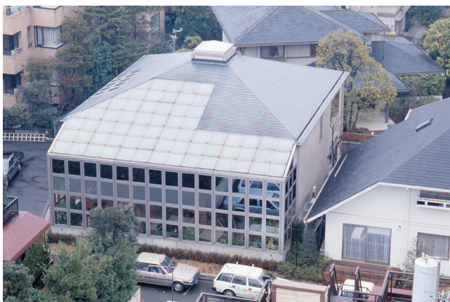
図1 電腦住宅南側全景。屋内外の環境／気象センサー群で温度・湿度・気圧・風速・風向・雨・照度などが常時測定され、半屋外空間を含む各部の窓はその測定結果に合わせてすべてコンピュータ制御で自動開閉する
