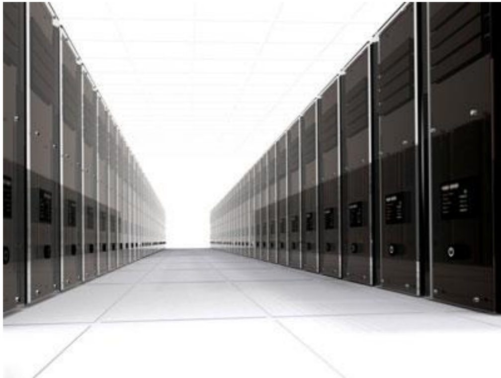
クラウドコンピューティング用 サーバーシステム
